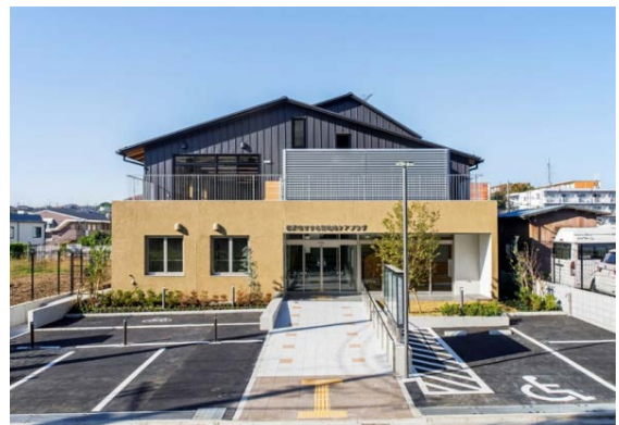
すすき野地域ケアプラザ新築工事での木造化(2階部分)整備
