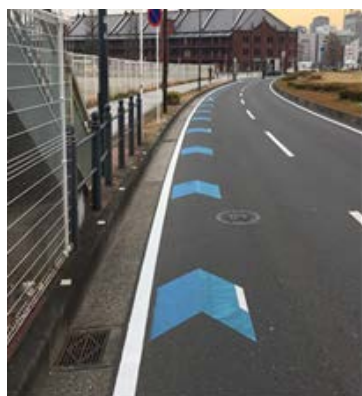
車道混在型(矢羽根型)(国際大通り(中区))
