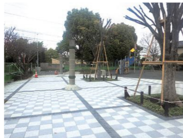
公園での透水性舗装等の整備による 雨水の保水・浸透機能の向上(都筑区)
