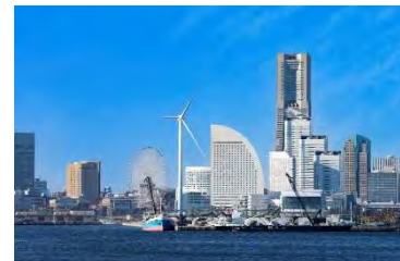
横浜市風力発電所（ハマウイング）
