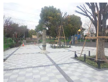
公園での透水性舗装等の整備による雨水の保水・浸透機能の向上（都筑区）
