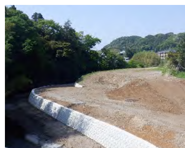
河川改修の状況（栄区）
