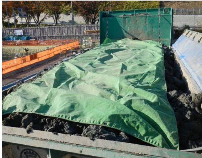
写真 4-4 環境保全のための措置の実施状況（工事用車両の荷台への防塵シートの敷設）
