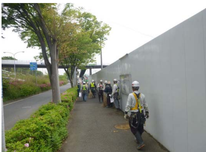
写真 4-3 環境保全のための措置の実施状況（工事現場周辺清掃）
