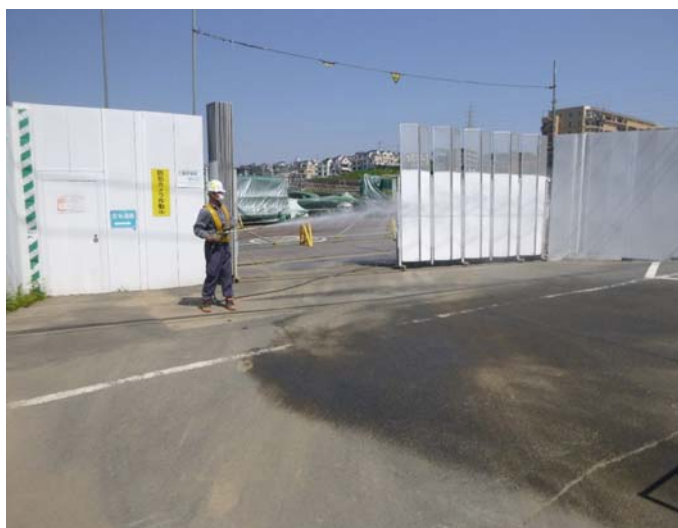
写真 4-2 環境保全のための措置の実施状況（工事現場での散水）
