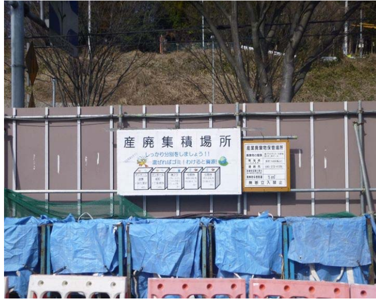
写真 3.3.3-1 環境保全のための措置の実施状況（建設廃棄物の分別処理）
