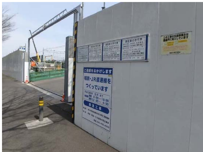
写真 4-9 環境保全のための措置の実施状況（工事計画の周知（工事案内掲示板））
