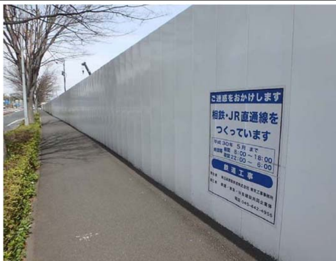
写真 4-1 環境保全のための措置の実施状況（仮囲いの設置）
