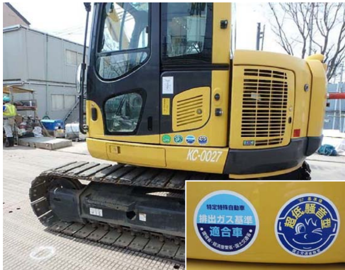
写真 4-5 環境保全のための措置の実施状況（環境対策型建設機械の使用）
