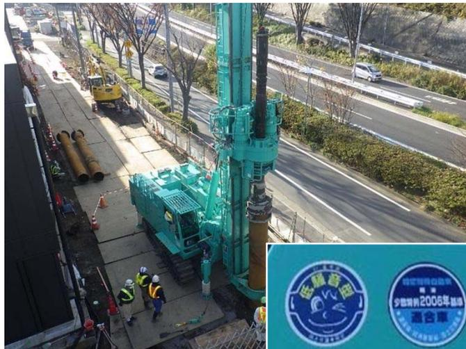
写真 4-3 環境保全のための措置の実施状況（環境対策型建設機械の使用）
