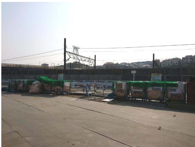
写真 3.3.1-1 環境保全のための措置の実施状況（建設廃棄物の分別処理）
