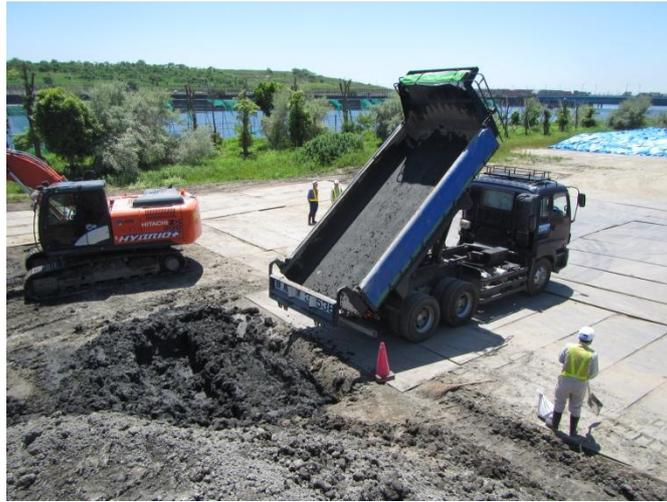
写真 2. 4. 3-1 (4) 環境保全のための措置の実施状況（建設発生土の再利用①）
