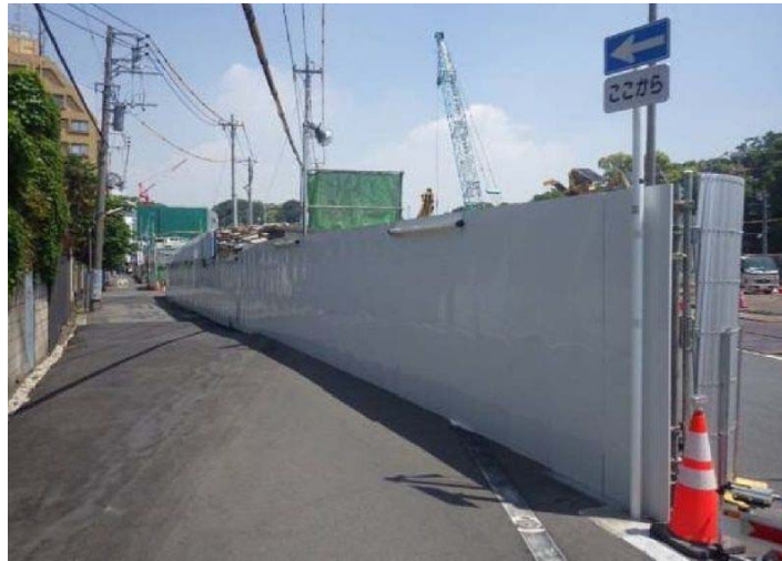
写真 2. 4. 4-1 (2) 環境保全のための措置の実施状況（仮囲いの設置②）
