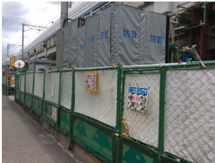
写真 2. 4. 4-1 (3) 環境保全のための措置の実施状況（防音シートの設置）
