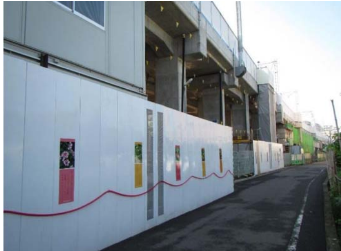
写真 2. 4. 4-1 (1) 環境保全のための措置の実施状況（仮囲いの設置①）
