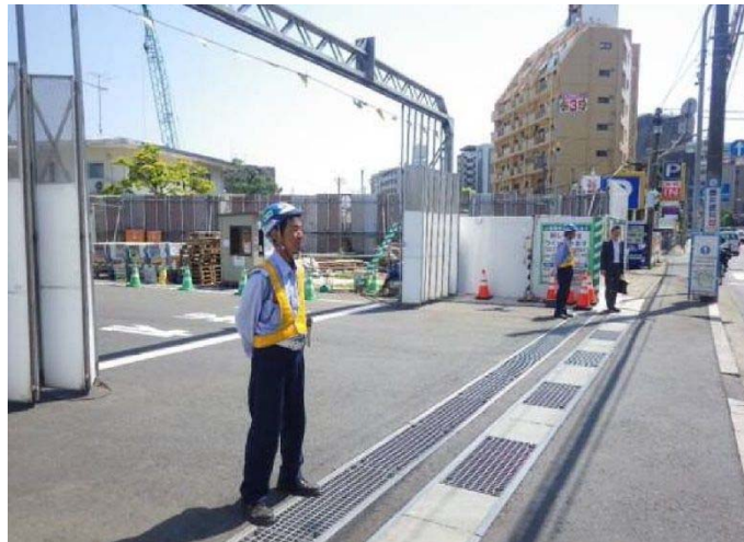
写真 2. 4. 4-8(1) 環境保全のための措置の実施状況（通行者の誘導）
