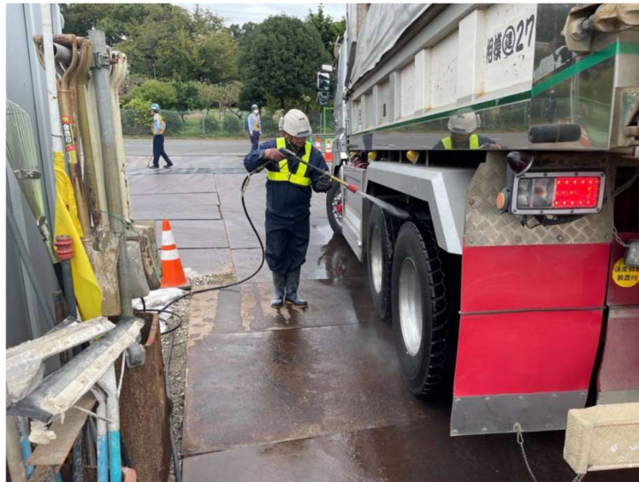
写真 2. 4. 4-2(3) 環境保全のための措置の実施状況（工事用車両のタイヤ洗浄）
