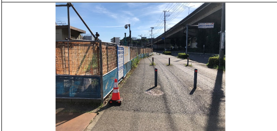
写真 2.4.4-1(2) 環境保全のための措置の実施状況 (飛散養生シートの設置)
