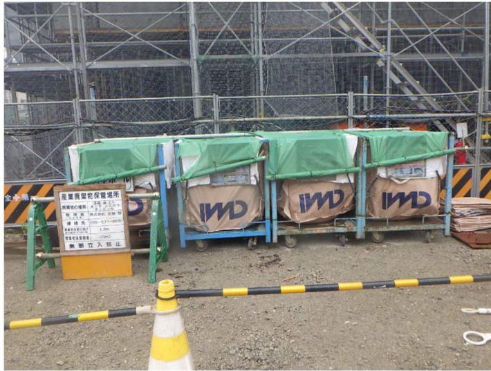
写真 2.4.3-1 環境保全のための措置の実施状況（建設廃棄物の分別処理）
