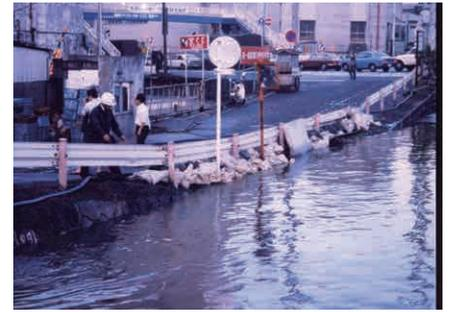
(上)地盤沈下による路上浸水が発生した横浜駅周辺(1970年代)
