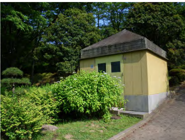
15 大池南部流入上流側に位置する ポンプ施設
