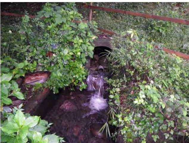
9 右岸水路流入部
