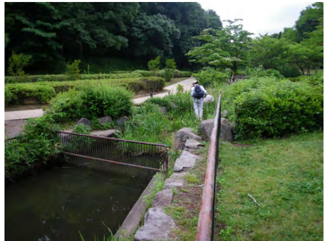
11 中池南部流入部全景
