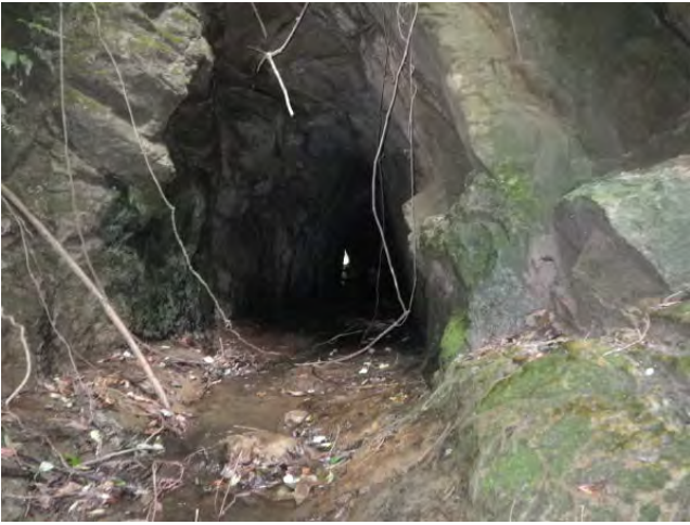
7 瀬上池流出部（洞門入口）
