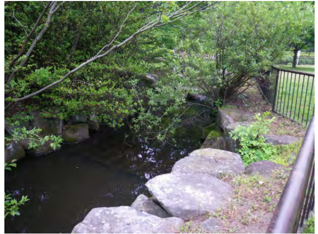
15 中池中央の島西側に位置する 施設（大池への流出部？）
