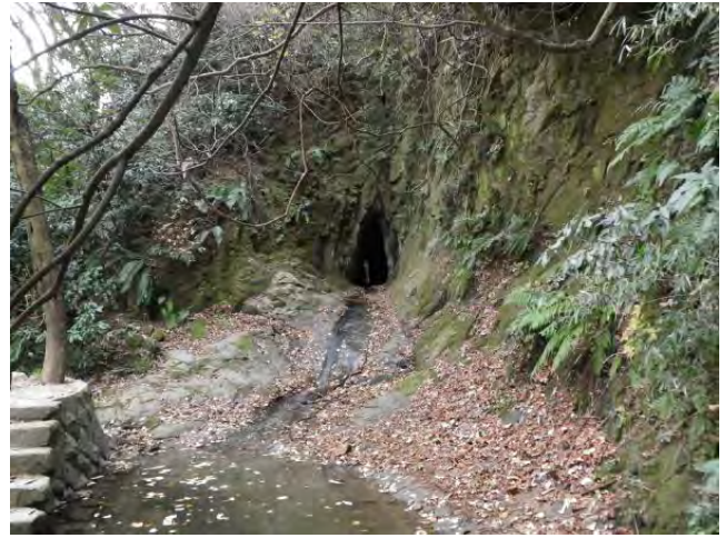
8 瀬上池流出部（洞門出口）
