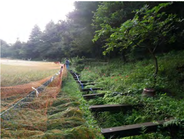
8 右岸水路全景
