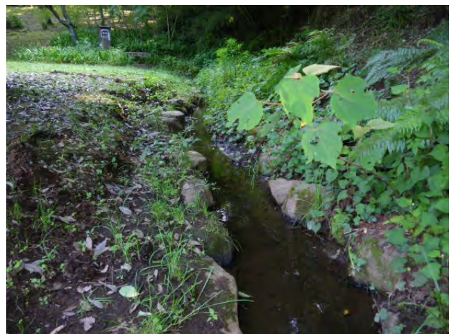
24 中池流入湧水点下流側水路
