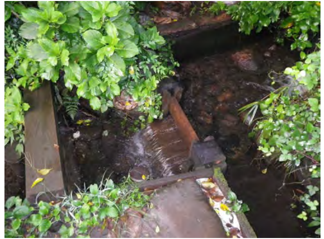
10 右岸、左岸水路分岐部
