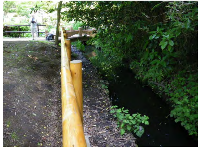
28 中池流出部水路
