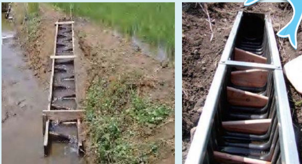
半割コルゲート管を利用した魚道 (出典：水田魚道づくりの指針)
