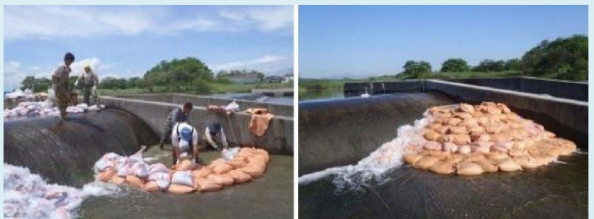
土嚢を使った簡易魚道の例
