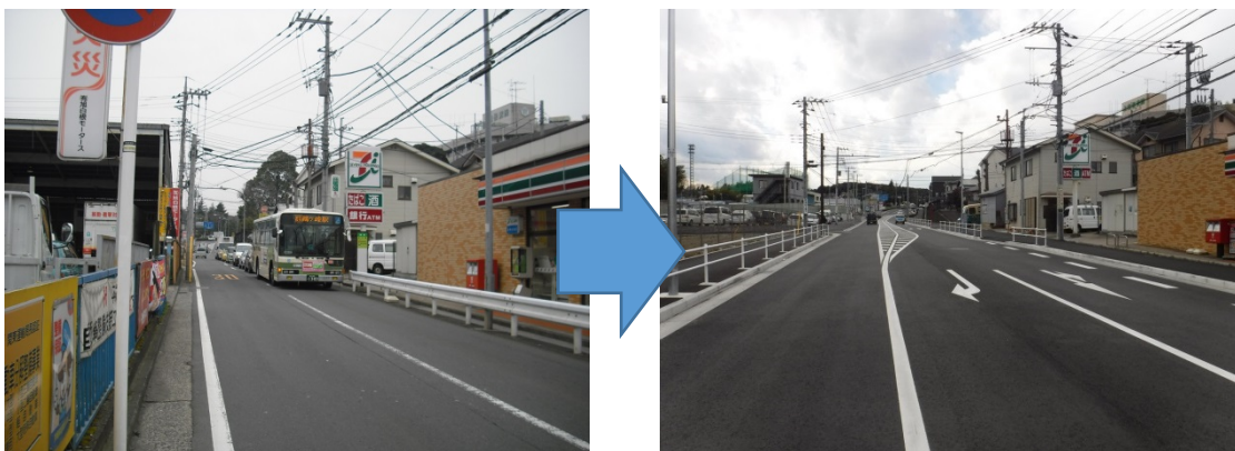
図 5-28 道路の拡幅整備（旭区）
