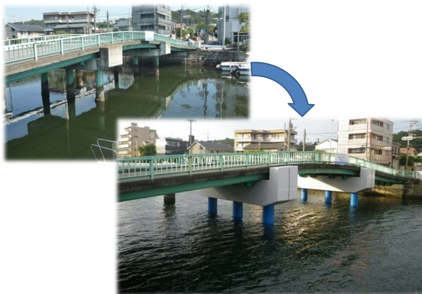
図 5-5 2 橋梁の耐震化（磯子橋）
