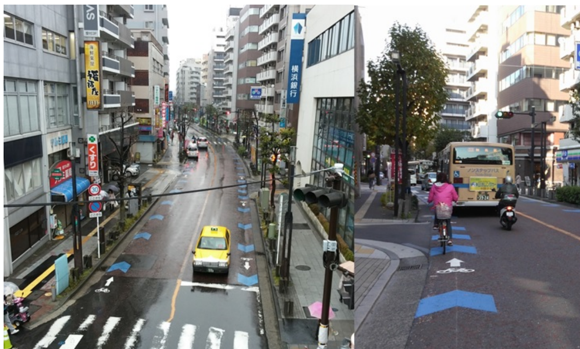
図 5-59 車道混在型（矢羽根）の設置
