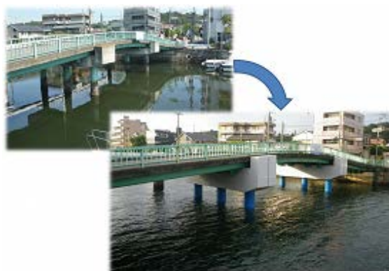
橋梁の耐震化（磯子橋）
