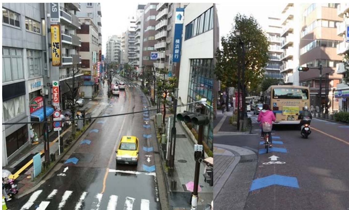
図 5-59 車道混在型（矢羽根）の設置
