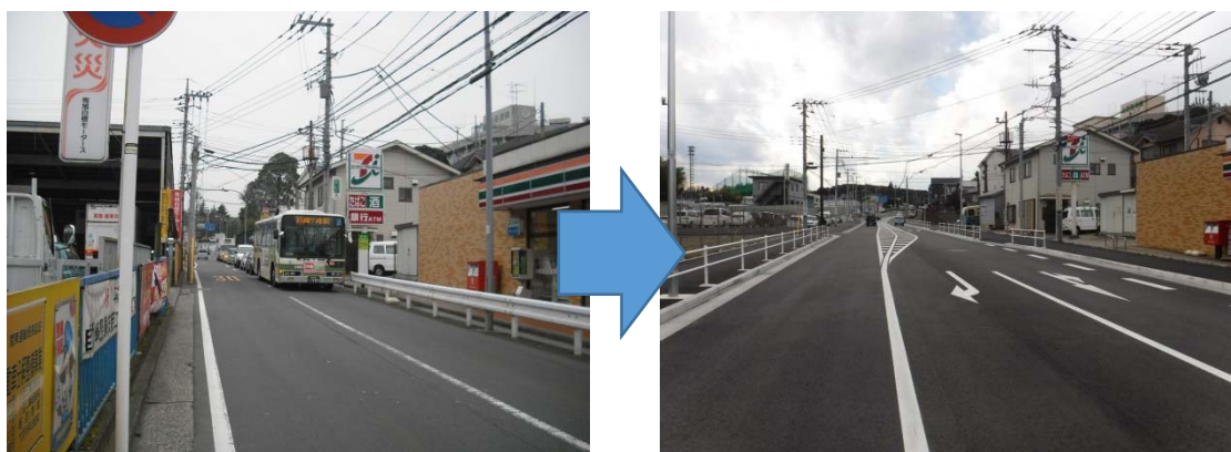
図 5-28 道路の拡幅整備（旭区）
