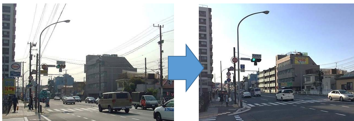
図 5-5 3 緊急輸送路の無電柱化（磯子区）
