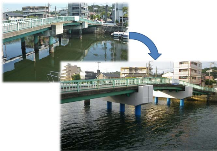
図 5-5 2 橋梁の耐震化（磯子橋）
