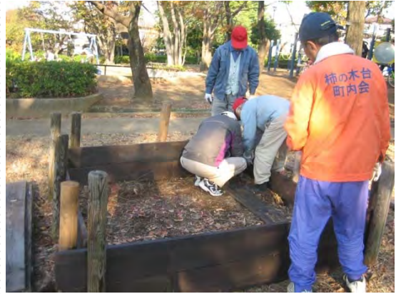
堆肥置き場修理の様子
