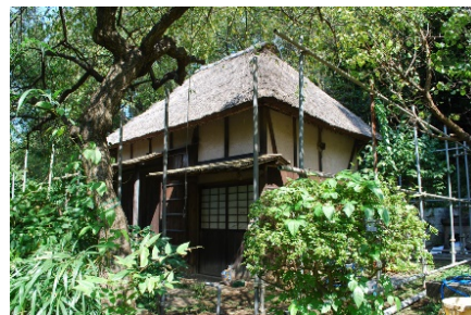
東屋（南東側外観）
