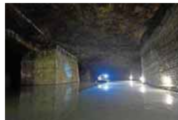
写真 OHYA UNDERGROUND ホームページより
