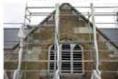
年代を重ねたジョイントの補修
