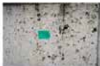
赤テープ 石の交換 既設所 黄色テープ 補修 122カ所 緑テープ ビン付も、184カ所 (スタンレス 48×180ミリ)
