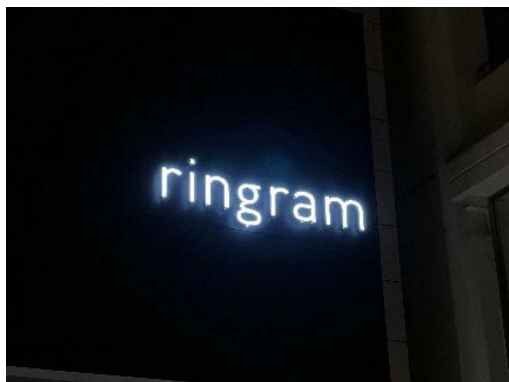
箱文字部分に限った内照式照明装置
