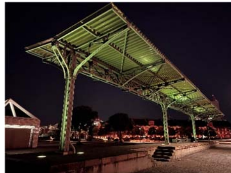
歴史的遺構の照明演出 (旧横浜港駅プラットフォーム)
