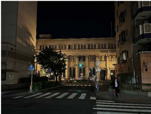
歴史的建造物をライトアップし、その周辺では控えめな照明とすることで、敷地同士の光に強弱をつけ、シンボル性を演出している（横浜郵船ビル）
