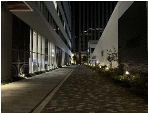
足元を照らし歩行者動線に沿って配置された照明
