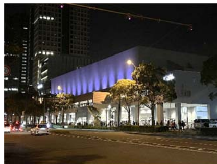
建物正面のゲート空間を限定的に演出 (びあアリーナ)
