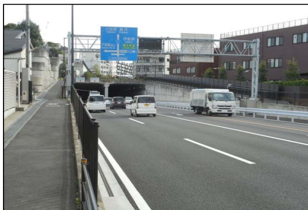
▲戸塚アンダーパス (平成 27 年 3 月オープン)
