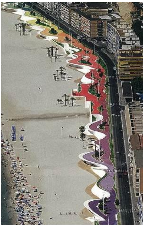
護岸施設のデザインにより水際線の連続性を強くイメージさせる（バレンシア／スペイン）
