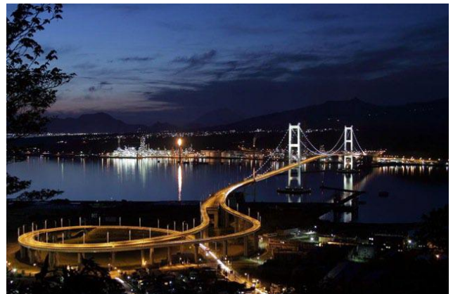
港のゲートとして 重要な景観要素となる橋りょう (室蘭)
