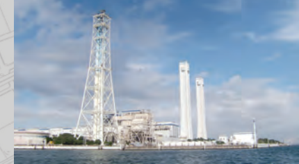
横浜火力発電所
