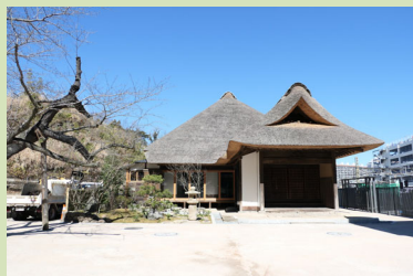
◆旧円通寺客殿（旧木村家住宅主屋） （金沢区瀬戸）
