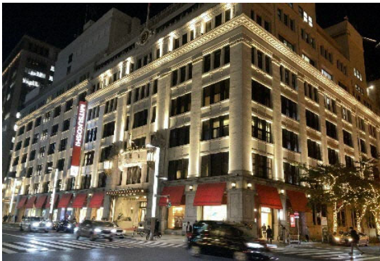
構造を生かした照明演出
