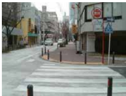
整備後（平成18年）
