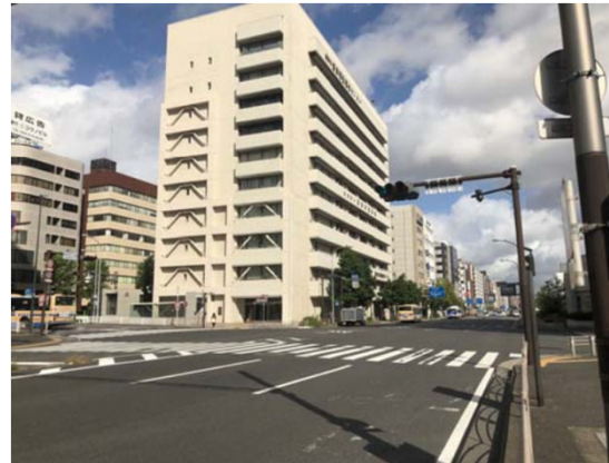
沿道建築物の耐震化の例
