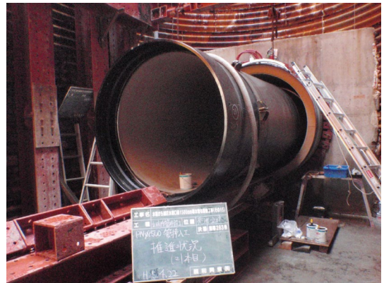
水場-麻溝減圧水槽間導水管耐震補強工事
