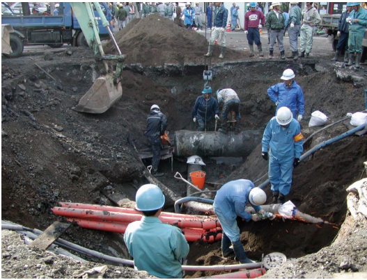
鶴屋町水道管破裂事故の復旧工事
