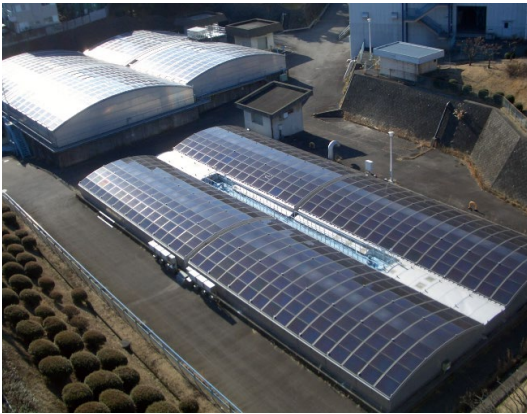
西谷排水処理施設太陽光発電設備
