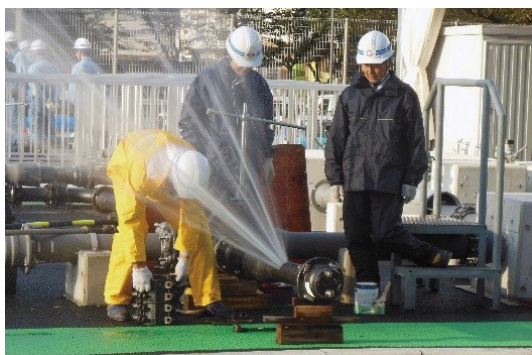
漏水修理研修
