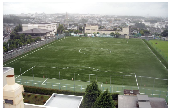
横浜FCのサッカー場(西谷3号配水池上部)
