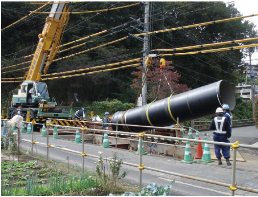
老朽管の布設替え
