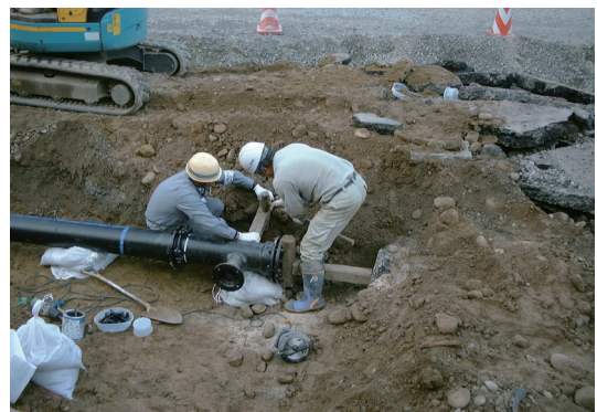
新潟県中越地震での応急復旧工事（小千谷市）
