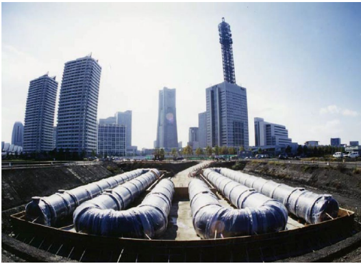
工事中の高島中央公園の災害用地下給水タンク みなとみらい21地区を望む
