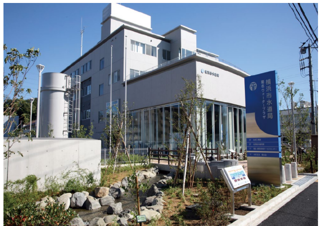
菊名ウォータープラザ 建物左に地上式災害用給水タンクが見える
