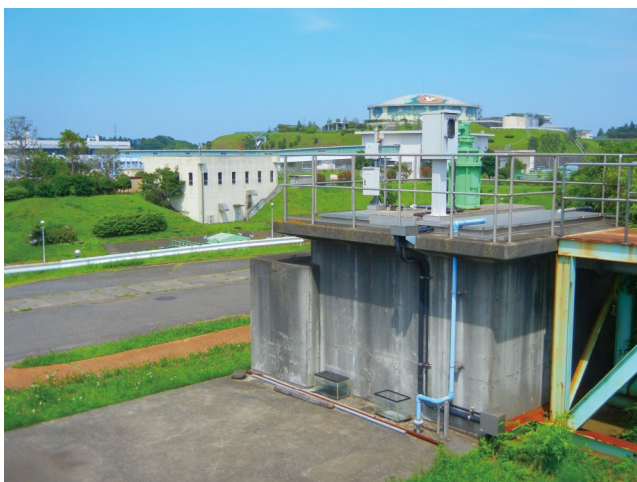
小雀浄水場 汚泥濃度調整槽
