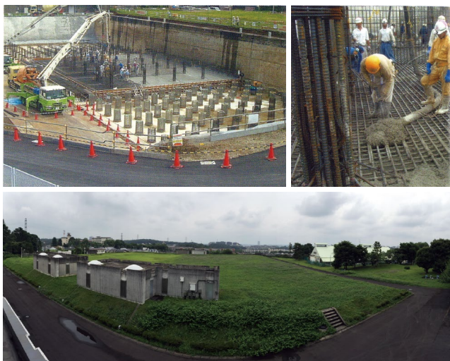
三保1号配水池（上：工事中）
