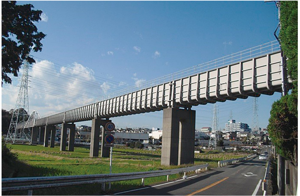
引地川水路橋
