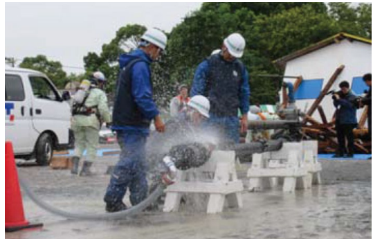
水道局と合同で参加した市総合防災訓練で修繕作業を行う管工事協同組合
