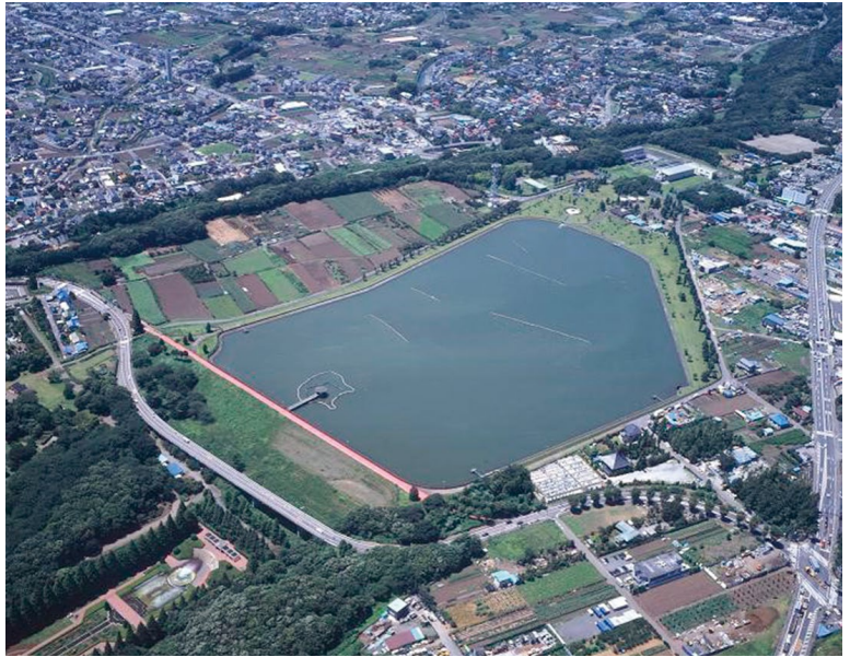
相模原沈殿池
