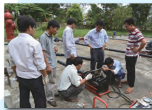
水道管の埋設場所の調査実習
