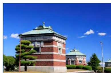
図 5.8 ろ過池整水室上屋
