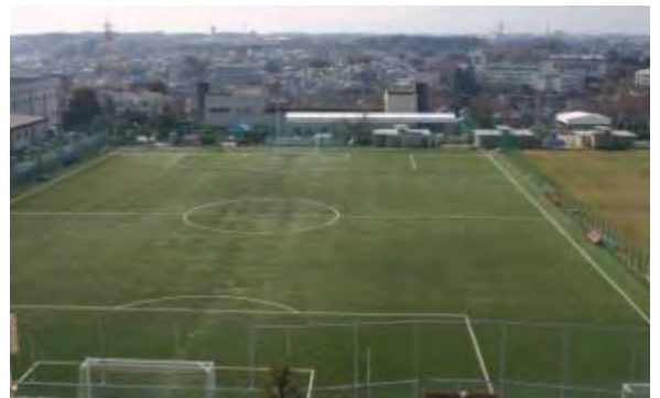
図 7.1 3号配水池上部
