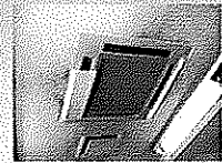
空調機の風よけを設置
