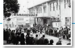
2代目西区庁舎 (昭和26年)
