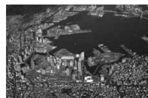
近年のみなとみらい21地区 (平成24年)
