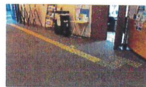
【点字ブロックの設置】
