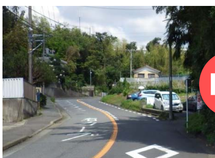
図11 モデル地点② 施工前
