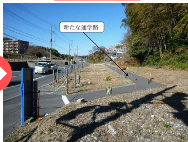
図8 施工後の道路
