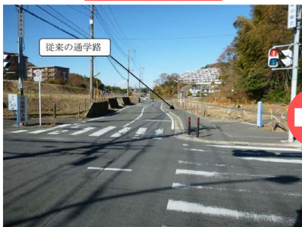
図7 施工前の道路
