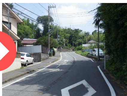
図12 モデル地点② 施工後
