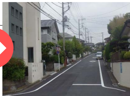
図10 モデル地点① 施工後
