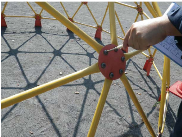
【ジャングルジムのボルト締め具合の点検】
