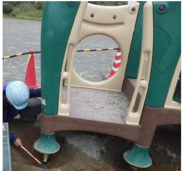
【遊具基礎の点検】
