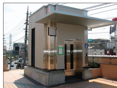
(南口厚木街道側に新設されたエレベーター)
