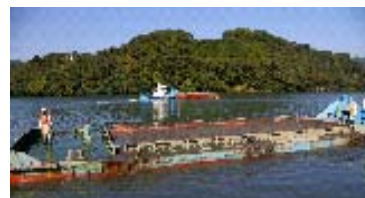
しゅんせつ工事
