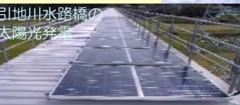
ろ過池覆蓋による太陽光発電システム
