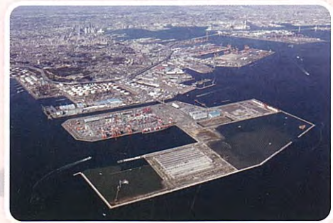
先進的な施設整備が進む 南本牧ふ頭
