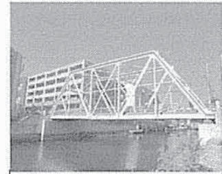
霞橋(旧江ヶ崎跨線橋) (平成25年度認定)
