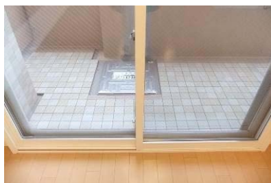
エコリノベーション 補助対象工事事例（内窓設置）
