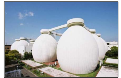
バイオマス発電（下水処理施設）
