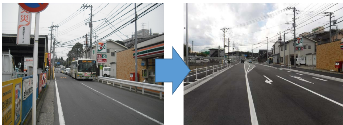
図 5-28 道路の拡幅整備（旭区）
