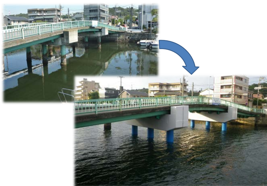
図 5-4 9 橋梁の耐震化（磯子橋）
