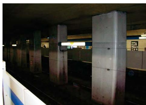
【中柱を補強した開削トンネル】
