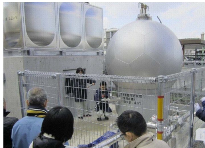
貯水機能付き給水管からの蛇口設置
