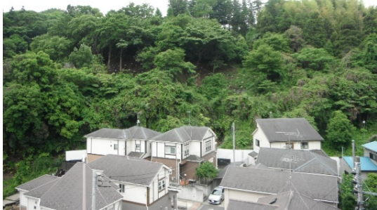
【写真】法面の整備 (保土ケ谷区/川島特別緑地保全地区)
