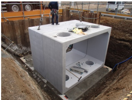
【写真】地下貯水槽の設置 (緑区)
