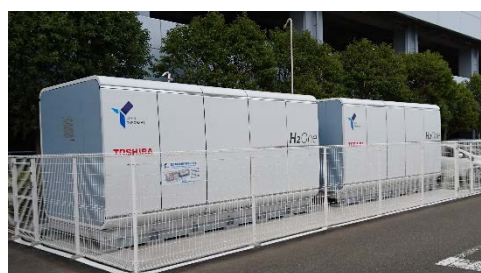
自立型水素燃料電池システム
