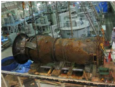
ポンプ再整備前
