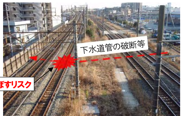
鉄道（軌道下の下水道管の耐震化を推進）
