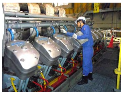
水再生センター施設・設備の点検
