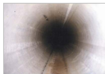
管更生による施工
