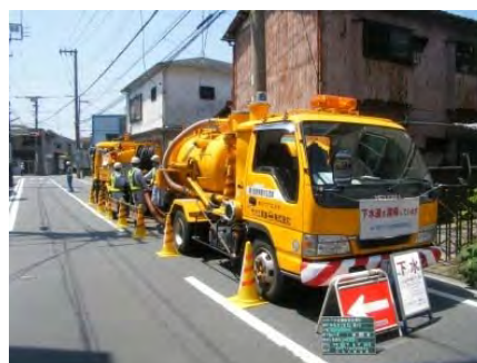
吸引車による下水道管の清掃
