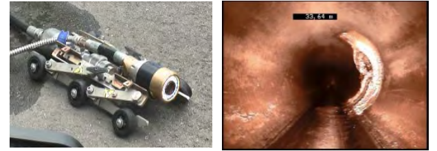
ノズルカメラによる調査
