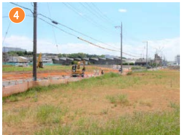
地区内で進められる造成工事
