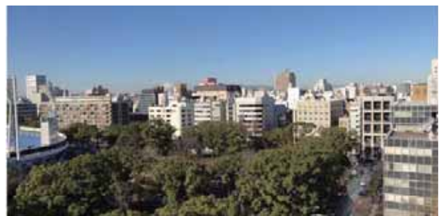
関内地区における中低層の建築物の街並み
