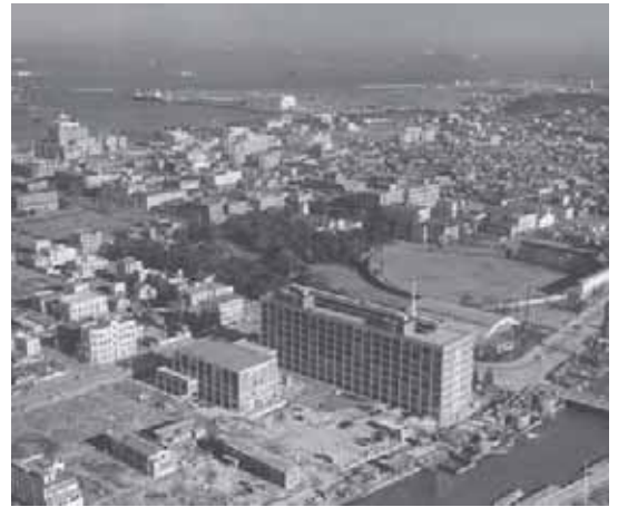
昭和34年竣工時
