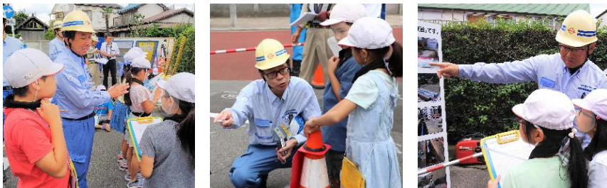
小学生を対象とした水道管取替え工事見学会
